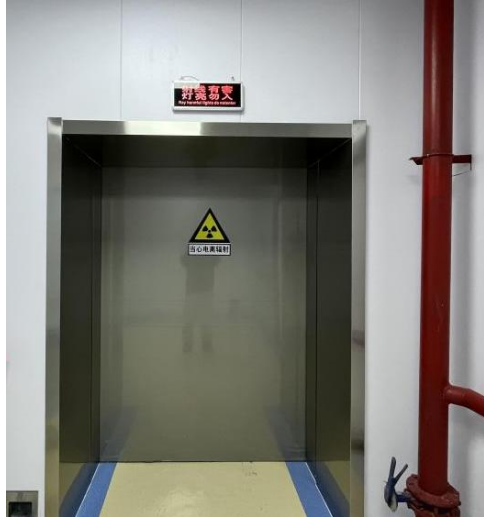
图 3-8 患者门工作状态指示灯、电离辐射警告标志
