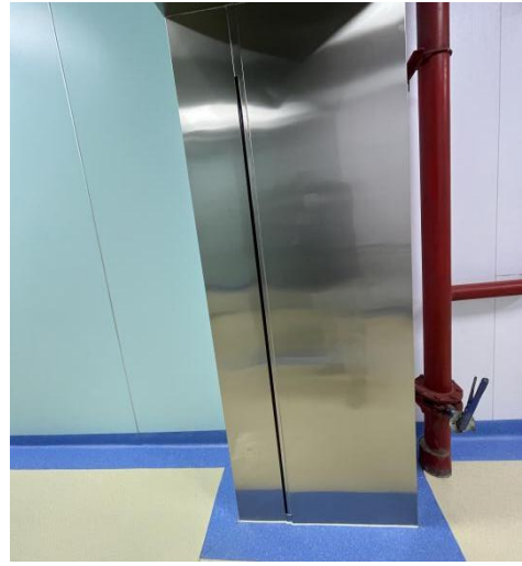
图 3-9 患者门光幕式红外防夹装置
