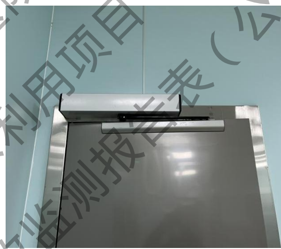
图 3-11 脚踏感应式电动工作人员门
